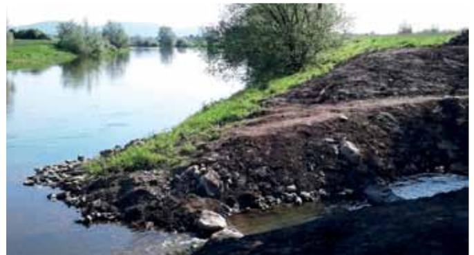
„Barrierefreiheit“ für den Herrengraben bei Kalletal – mit Riegeln aus Blocksteinen wurde eine Laichtreppe errichtet (re.vo.)
