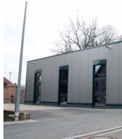
Außenansichten der AGA-Abteilung Industrier
